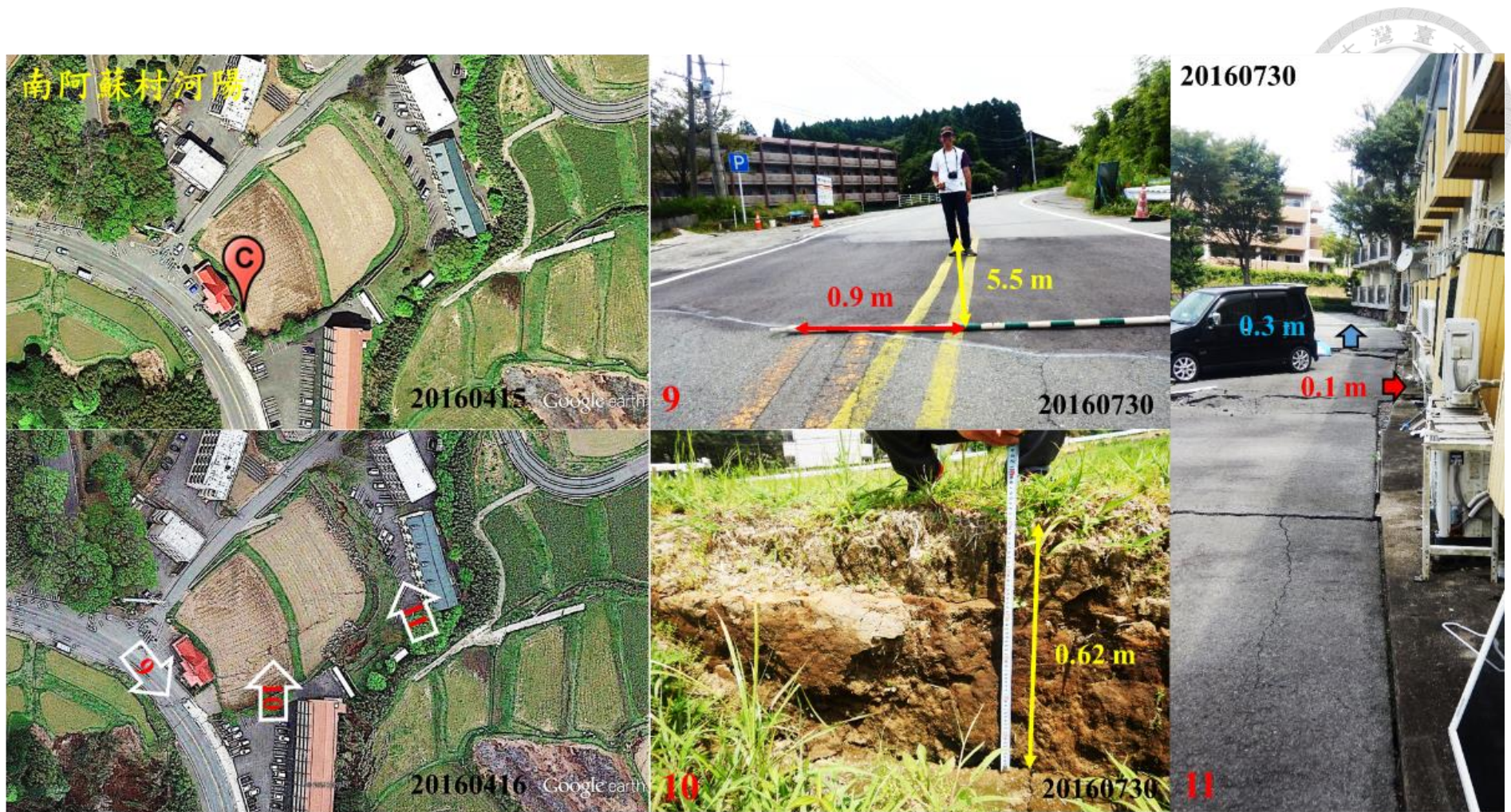
圖 4.7 現地踏勘-黑川(C)，斷層於此區水平錯移約 0.9 公尺
