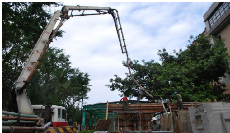
圖 3-9 上部結構澆置
