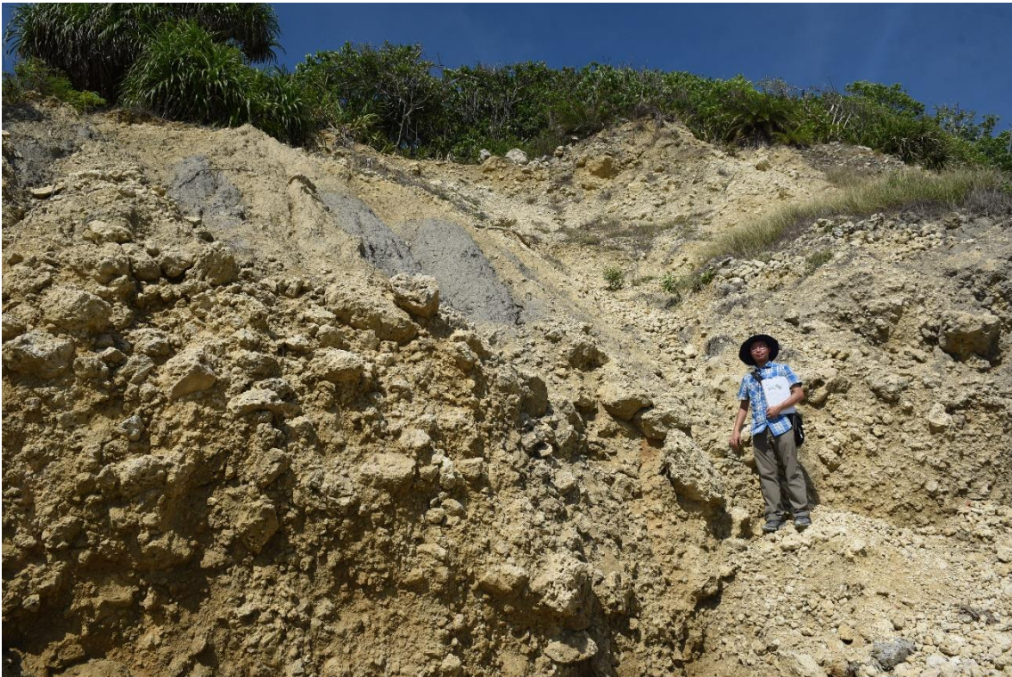
圖 2.11 泥岩覆蓋於崩積層上之露頭
