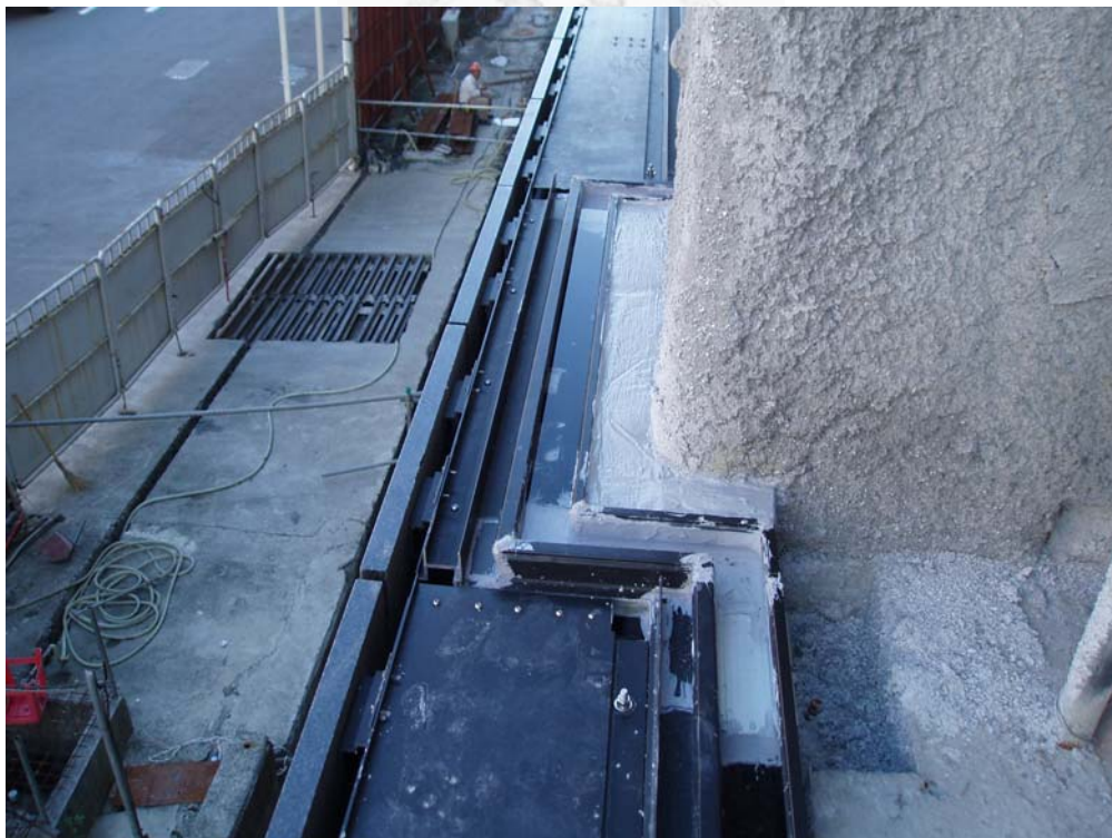
圖 3.32 帷幕牆單元防水試水
