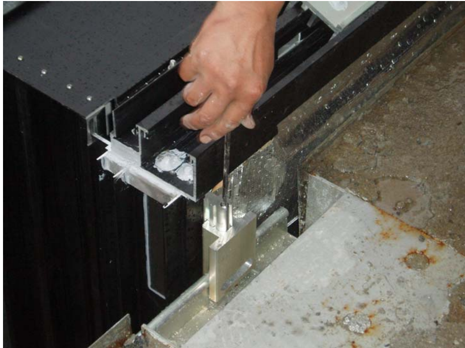
圖 3.30 帷幕牆單元吊裝後精度調整
