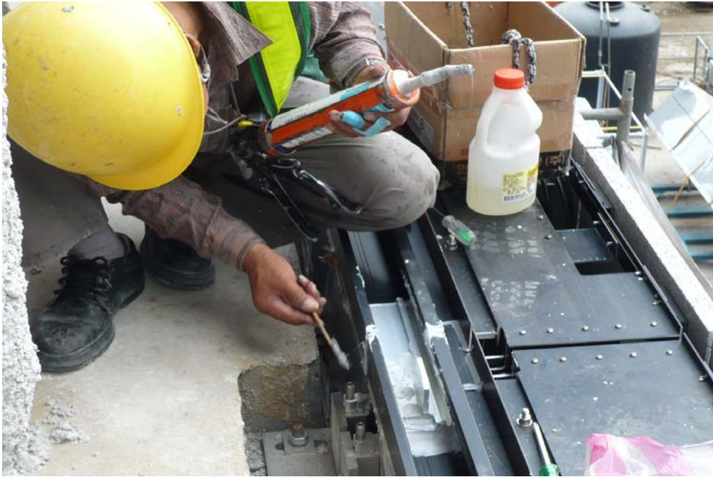
圖 3.31 帷幕牆單元檔塊安裝及防水施作
