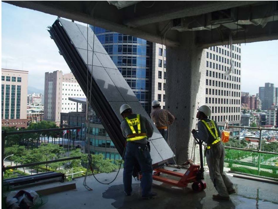
圖 3.27 帷幕牆單元吊裝施工
