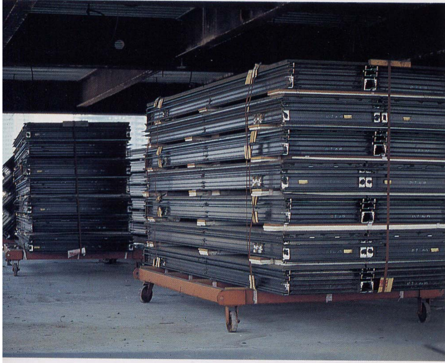
圖 3.26 帷幕牆板片吊放至施工樓層
