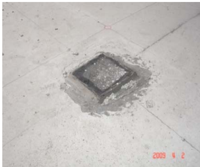
圖 3.16 樓板放樣觀測孔
