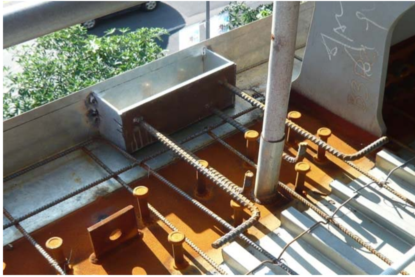
圖 3.19 預埋鐵件安裝施工
