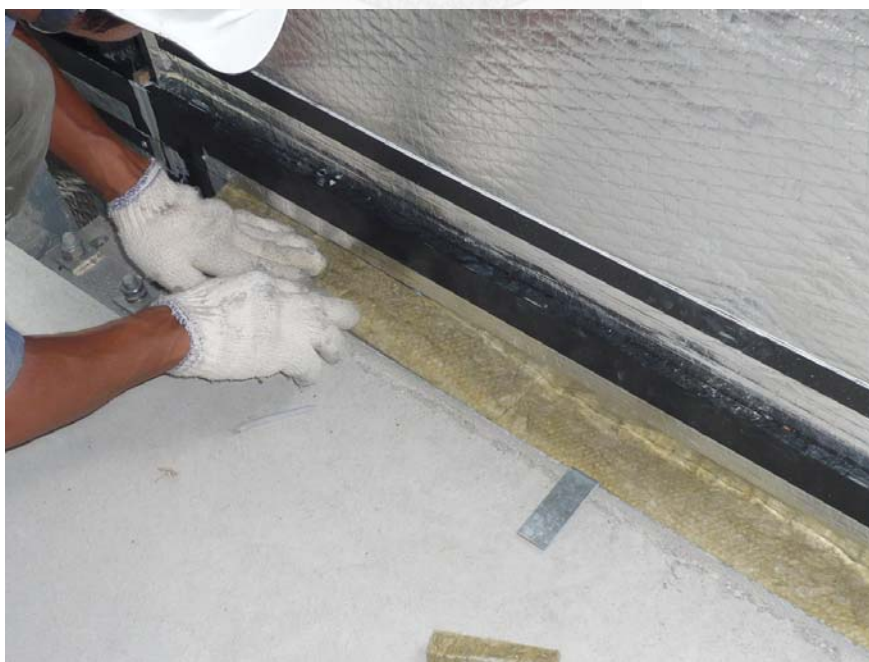
圖 3.33 帷幕牆單元層間塞施工
