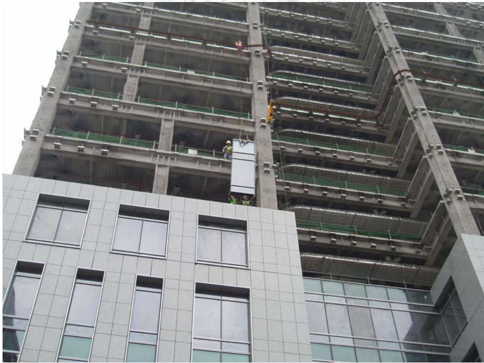
圖 3.28 帷幕牆單元吊裝施工
