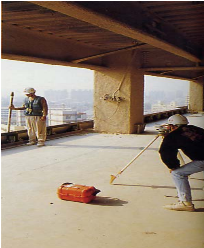
圖 3.29 帷幕牆單元吊裝時精度測量
