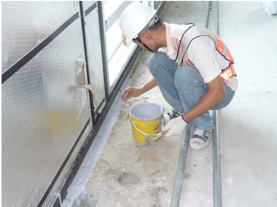
圖 3.34 帷幕牆層間塞阻煙劑施工
