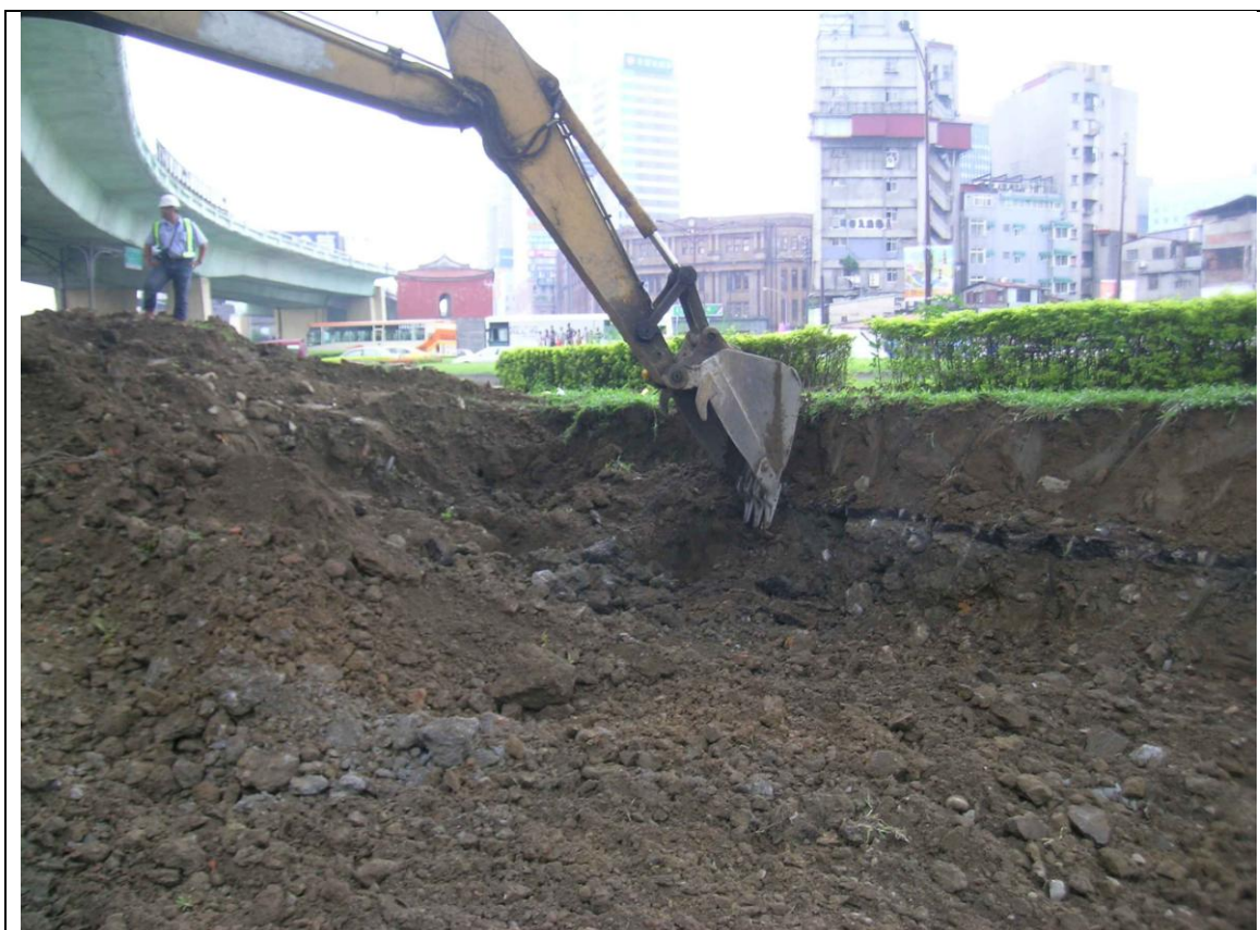
圖二- 16 : C5 區，挖土機清除 L0 的景象，挖土機挖斗附近地層即為中華商場時代地層（引自劉益昌 2008a）
