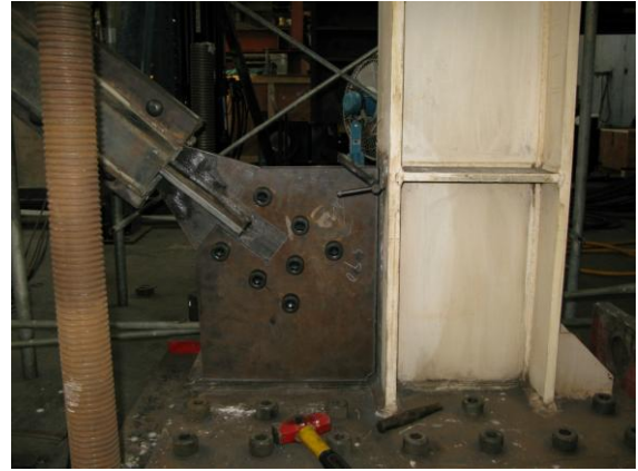
(b) 試體三下端接合板 安裝過程
