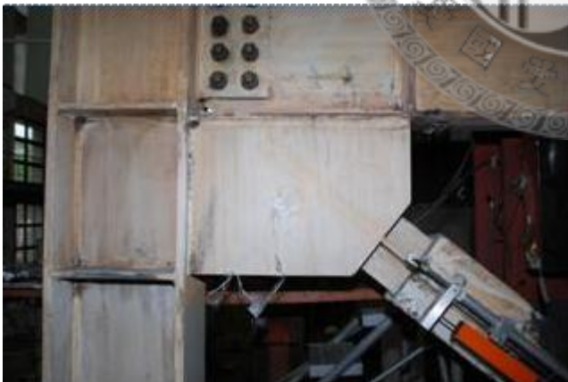
(e) 試體五上端接合板降伏(正面) (+0.02 rad)
