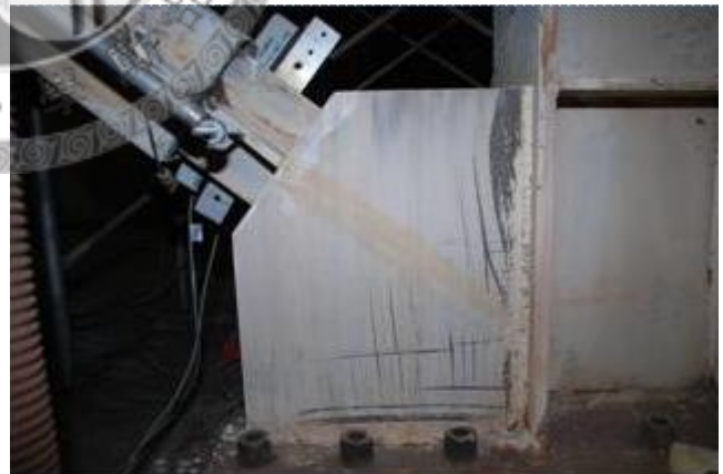
(f) 試體五下端接合板降伏(正面) (+0.02 rad)
