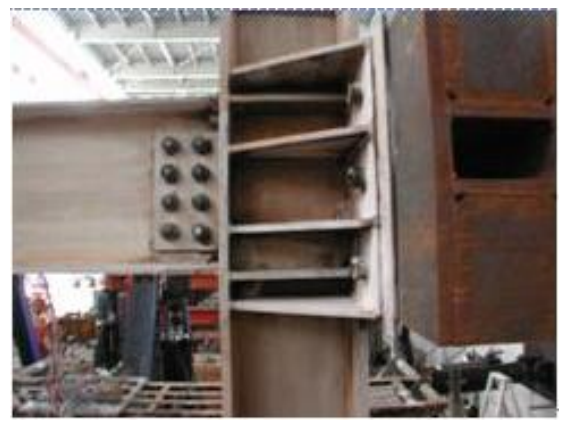
照片 3.6 與千斤頂連接端之梁柱接頭
