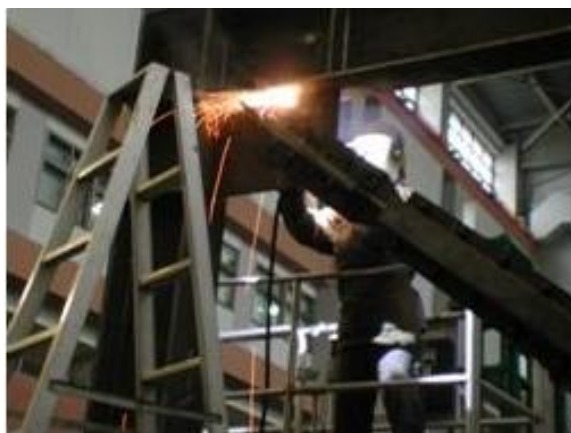
照片 3.5 接合板與梁、柱填角焊接
