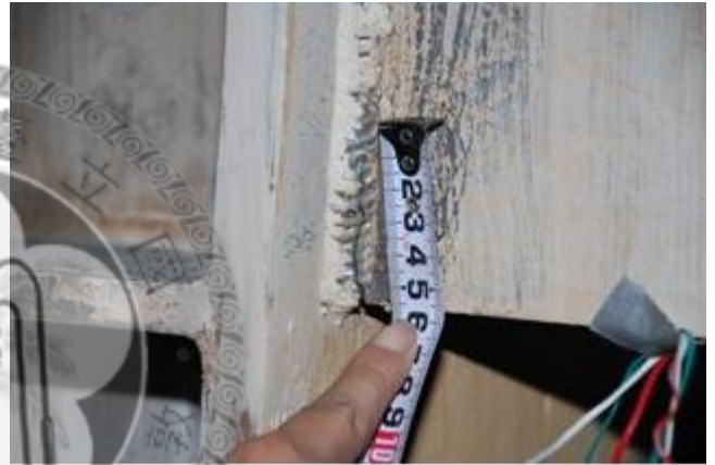
(d) 試體五上端接合板與柱焊道開裂(正面)(-0.025 rad)
