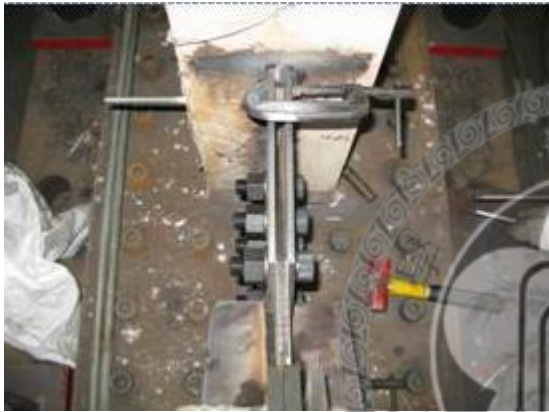
(c) 試體三下端接合板安裝過程(上視)
