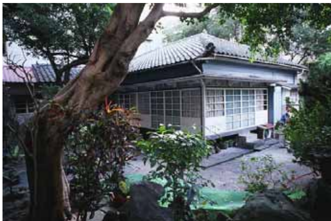
【圖 41】市定古蹟 - 青田街日式宿舍楊宅。
