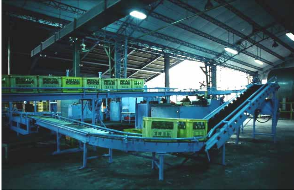
【圖 68】台北市建國啤酒廠啤酒生產線。
