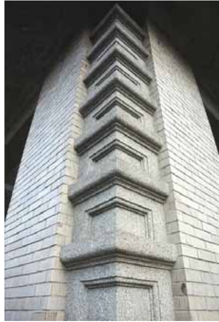
【圖 36】稅務出張所入口柱身細部，細膩的洗石子工法表現出日據時期做工講究的特點。
