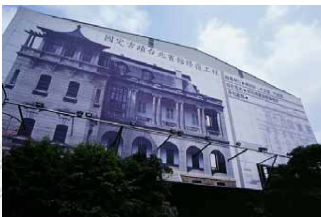
【圖 17】台北賓館修復工程外部美化。
