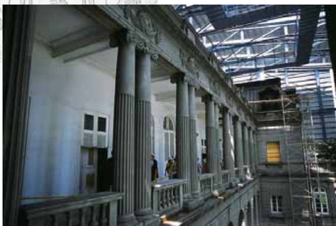
【圖 18】台北賓館修復工程二樓。
