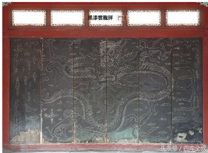
圖Ⅲ-31 「楔賞亭」明間中之黑漆雲龍屏門。
