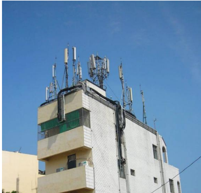
圖 5 臺中縣烏日鄉學田路一處共站基地台 資料來源：NCC 中區監理處
