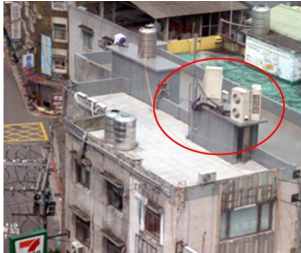
圖 7 基地台天線偽裝成冷氣室外機
