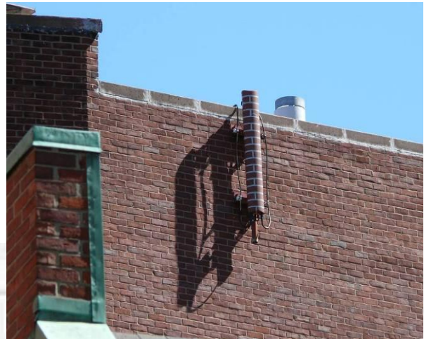
圖 10 美國麻州波士頓市區磚牆上的 無線電發射天線
